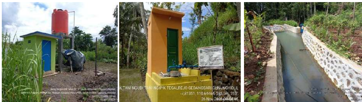
Gambar 3.8. Beberapa Kegiatan DAK Pembangunan Dam Parit dan Sumur Dangkal
